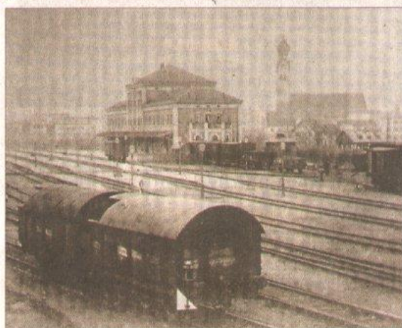
Die Kugleralm in Deisenhofen war anfangs ein Bierauschank für die Arbeiter, die die Maximiliansbahn errichteten. Schon bald wurde sie ein beliebtes Ausflugslokal. Links der Rosenheimer Bahnhof, das Ziel der 73,6 Kilometer langen Strecke von München ins Inntal.
