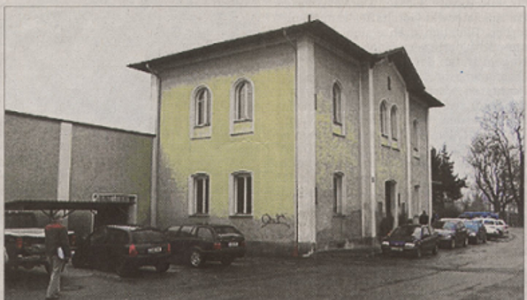
Der Pilgerbahnhof Regensburg-Prüfening umfasst nicht nur das Empfangsgebäude, sondern auch Wohnhäuser, Nebengebäude und einen Garten. Fotos: Bahn AG
